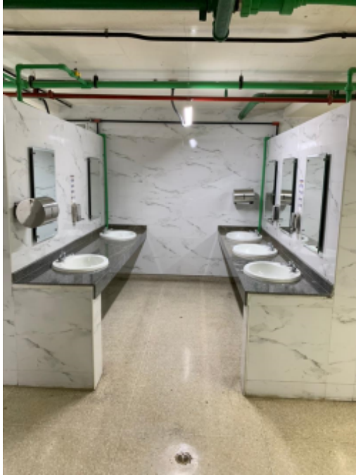
Instalaciones sanitarias 1.jpg
